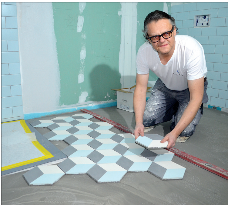
Thomas Hofmann beim Verlegen der sechseckigen Zementplatten im Bad. Rechts: Plattenboden in Perfektion.
